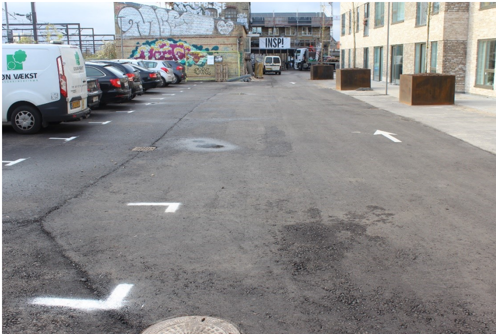
FIGUR 18. Den store handicapparkeringsplads er placeret længere end de 30 meter fra indgangen til INSP!, som SBI-anvisning 258 anbefaler.
