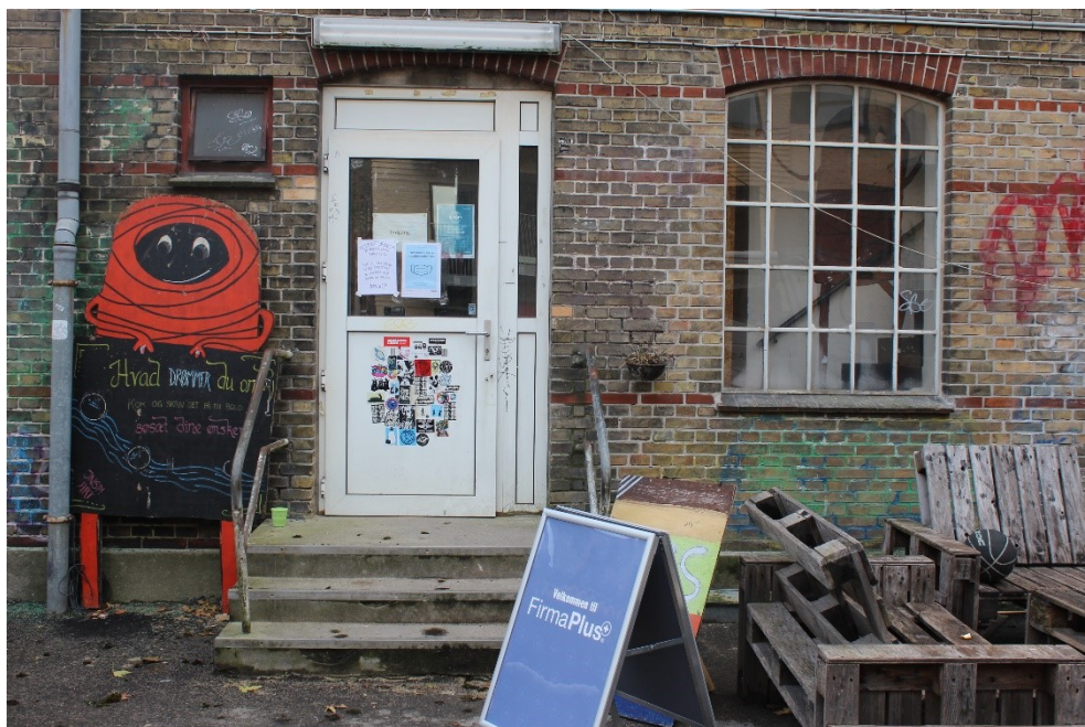
FIGUR 11. Den sekundære indgang til INSP! Her etableres en trappelift, som giver adgang til bygningens handicaptoilet.
