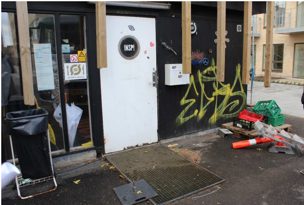
FIGUR 10. Hovedindgangen til INSP!
